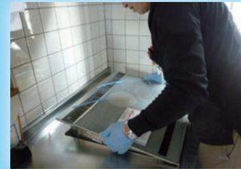
ガス台からIHへの取り替えIHが古くなったので新しいIHへの取り替え、どちらもOKです。ガスからのお取替えの時は電気工事が必要になります。
