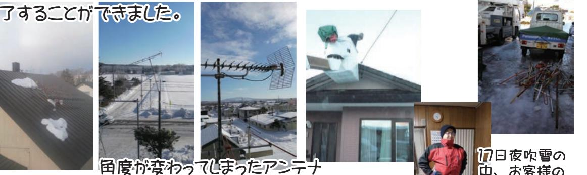
角度が変わってしまったアンテナはポールを新しくし固定し直します。高所作業車で高い場所も安全に作業します。
