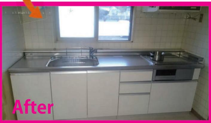
築30年の住宅の流し台です。水道の蛇口の位置が高くてシャワーもついていないため食器洗いの時に水はねが気になるのご相談でした。ガスレンジも今後は安全なIHに交換したいというご希望もありました。流し台を丸ごと取り外し、同じ位置に既製品のキッチンそのまま設置する、という方法をご提案しました。蛇口の位置も下がりシャワー付きのものに変更されています。ガス台は埋め込みタイプのIHクッキングヒーターでスッキリと収まっています。火事の心配もなくなりました。
